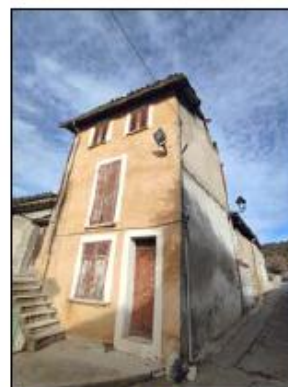
Immeuble de logement vacant
