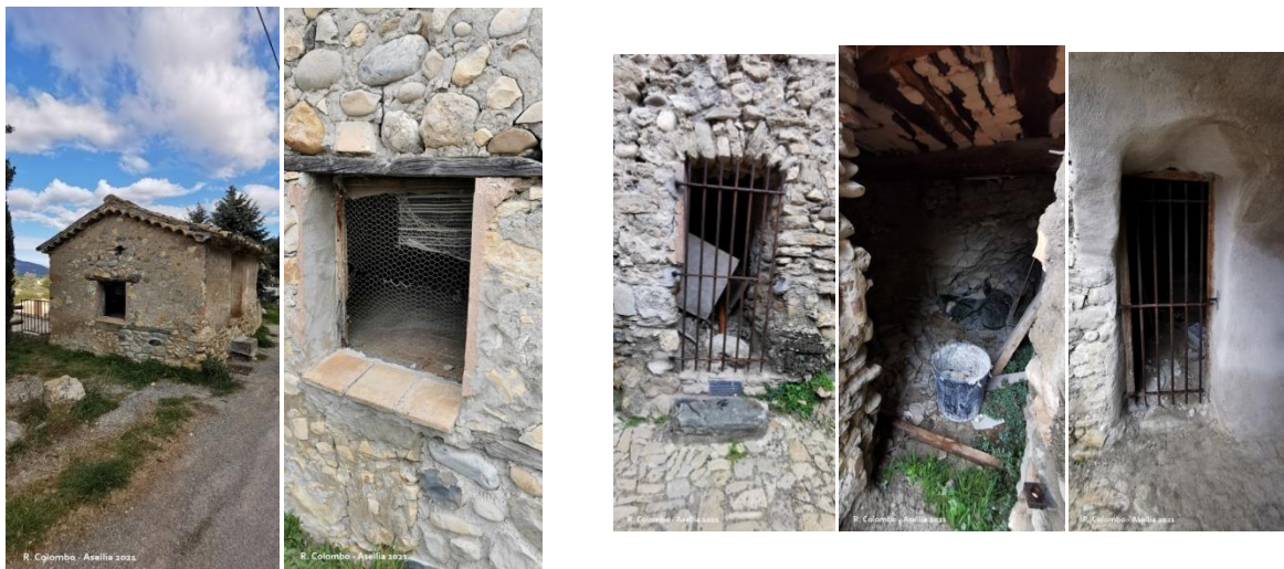
Ancien four, gîte potentiellement aménageable pour le Petit Rhinolophe, à faible coût
