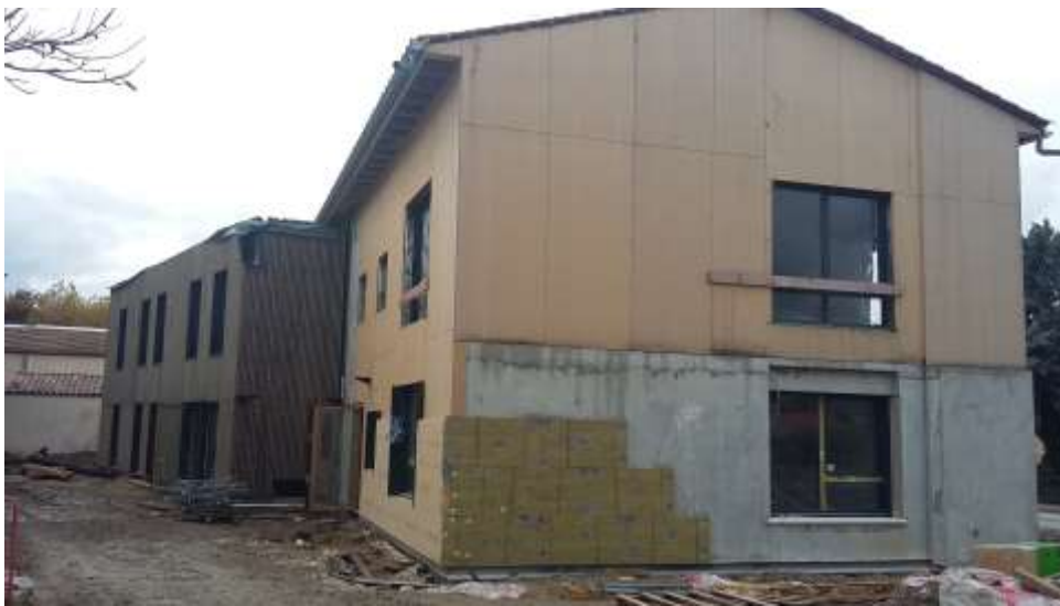
Photo 1 : isolation extérieure, avant finitions (novembre 2018)
