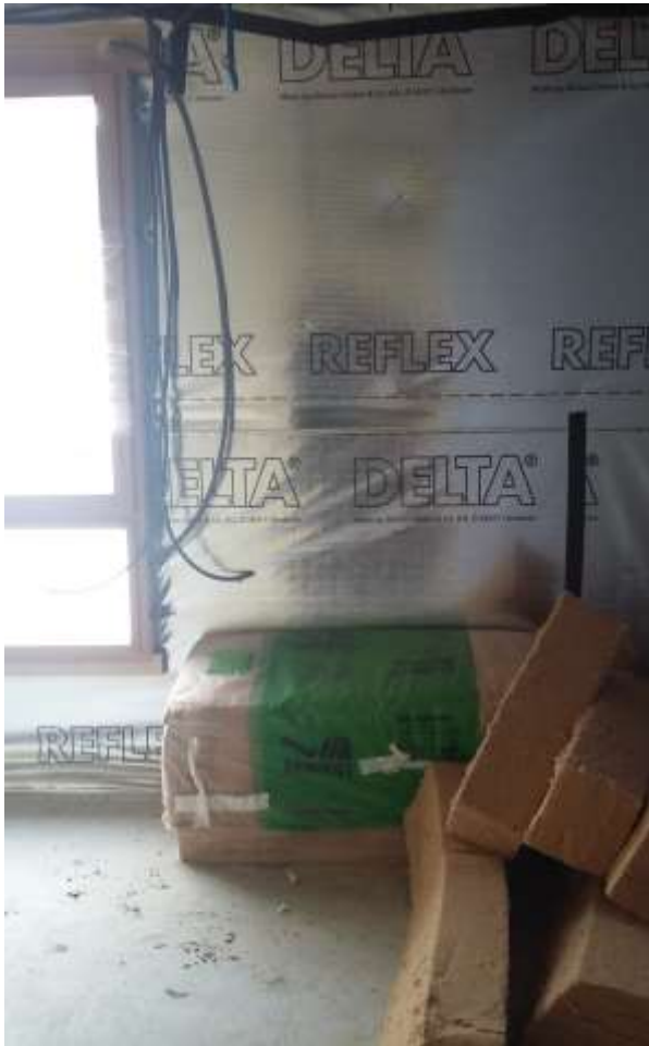
Photo 3 : isolation intérieure (laine de bois) et pare vapeur, étanchéité renforcée (novembre 2018)
