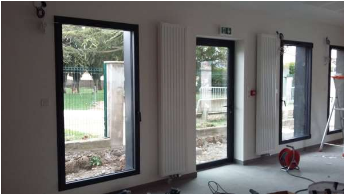
Photo 3 : salle de restauration, le chauffage est raccordé au réseau de chaleur bois de la commune (photo décembre 2019).
