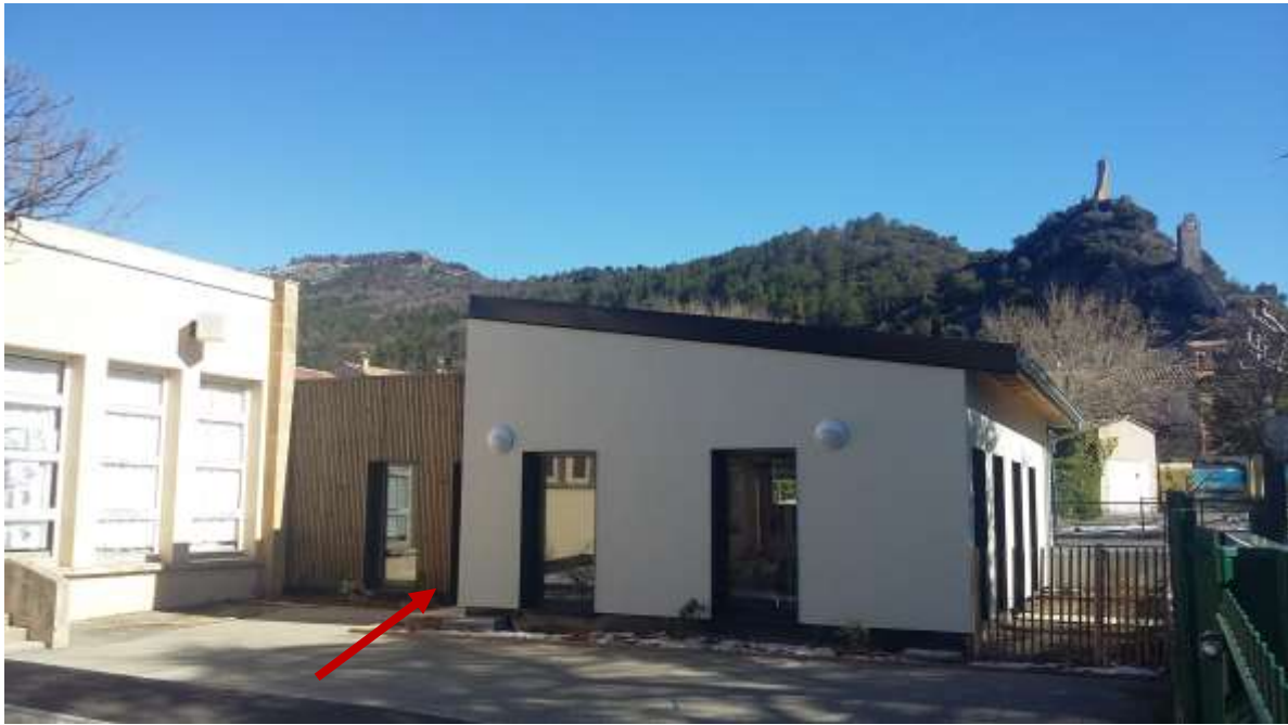
Photo 5 : accès au restaurant directement par la cour de l'école maternelle (photo février 2020).
