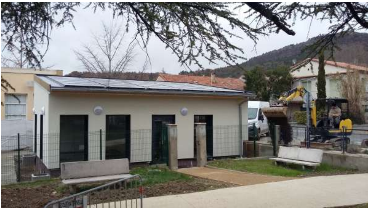
Photo 4 : le lien avec le jardin public. Les panneaux solaires photovoltaïques en toiture (financés par un collectif citoyen) ont permis de diminuer le coût de celle-ci (photo décembre 2019).
