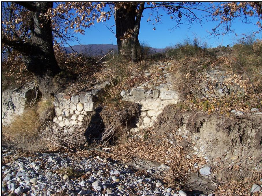
*Photo 8: Le Vançon –Ouvrages, anciens, de protection de la berge rive droite en amont de la RD4.*
